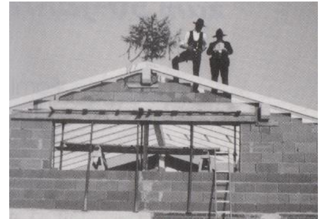
Richtfest des Hallen Anbaues 1998
