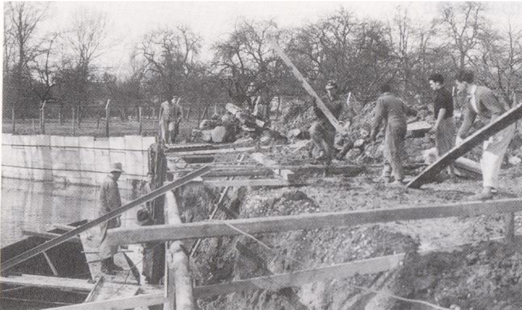
Die Verankerungen werden gesetzt
