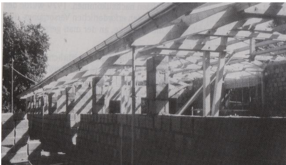
Das neue Clubhaus kurz vor dem Richtfest
