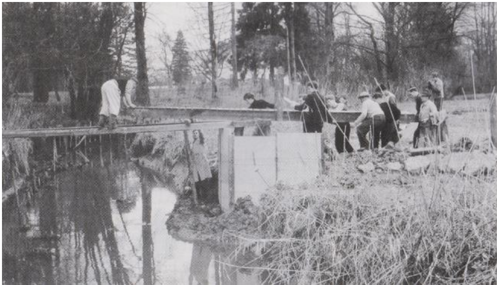
Verlegung des neuen Holzsteges
