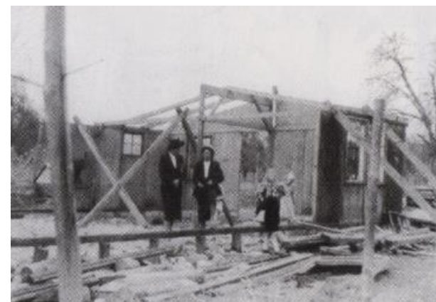
WVF Damen begutachten Fortschritt am Bau der Baracke
