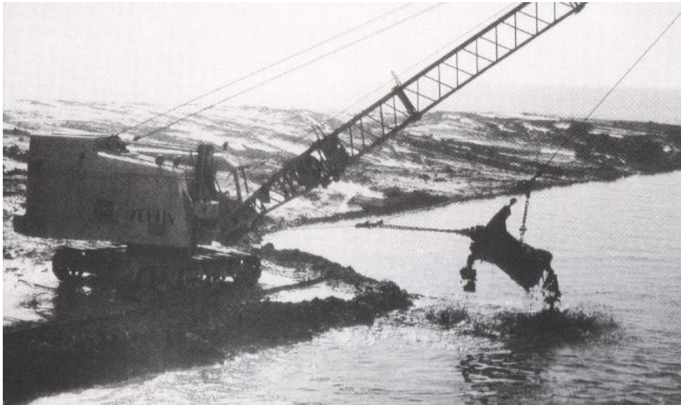
Schweres Gerät beim Abtragen der Sandbänke
