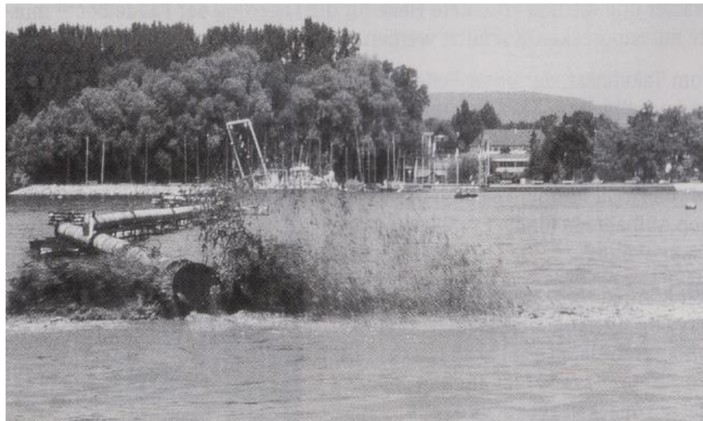
Entsorgung des Aushubes in den See
