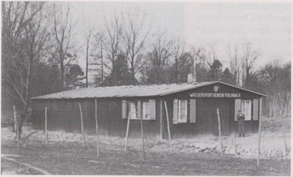
Das Bootshaus ist fertig
