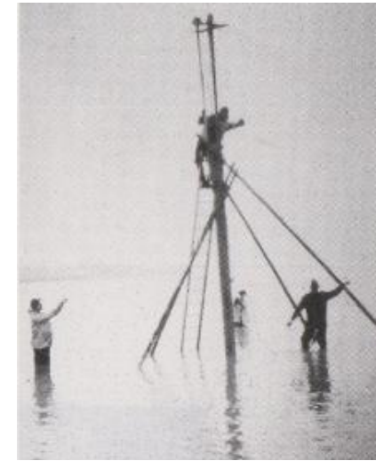
Halsbrecherisches Schlagen von Dalben
