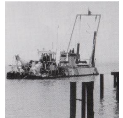
Schwimmbagger vor Fischbach
